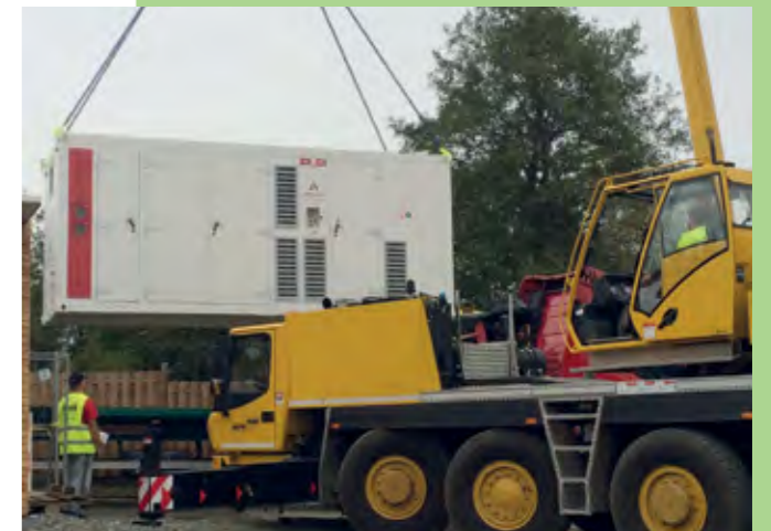
Installation eines AREVA-Elektrolyseurs im Projekt Smart Grid Solar in Bayern.
